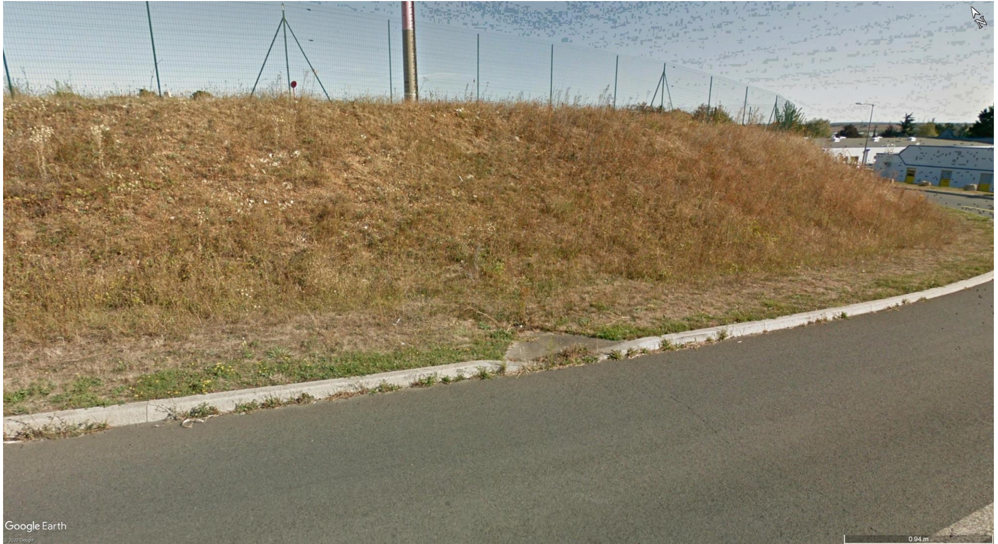
Figure 3 : Localisation de l'avaloir recevant la surverse (3/3)
