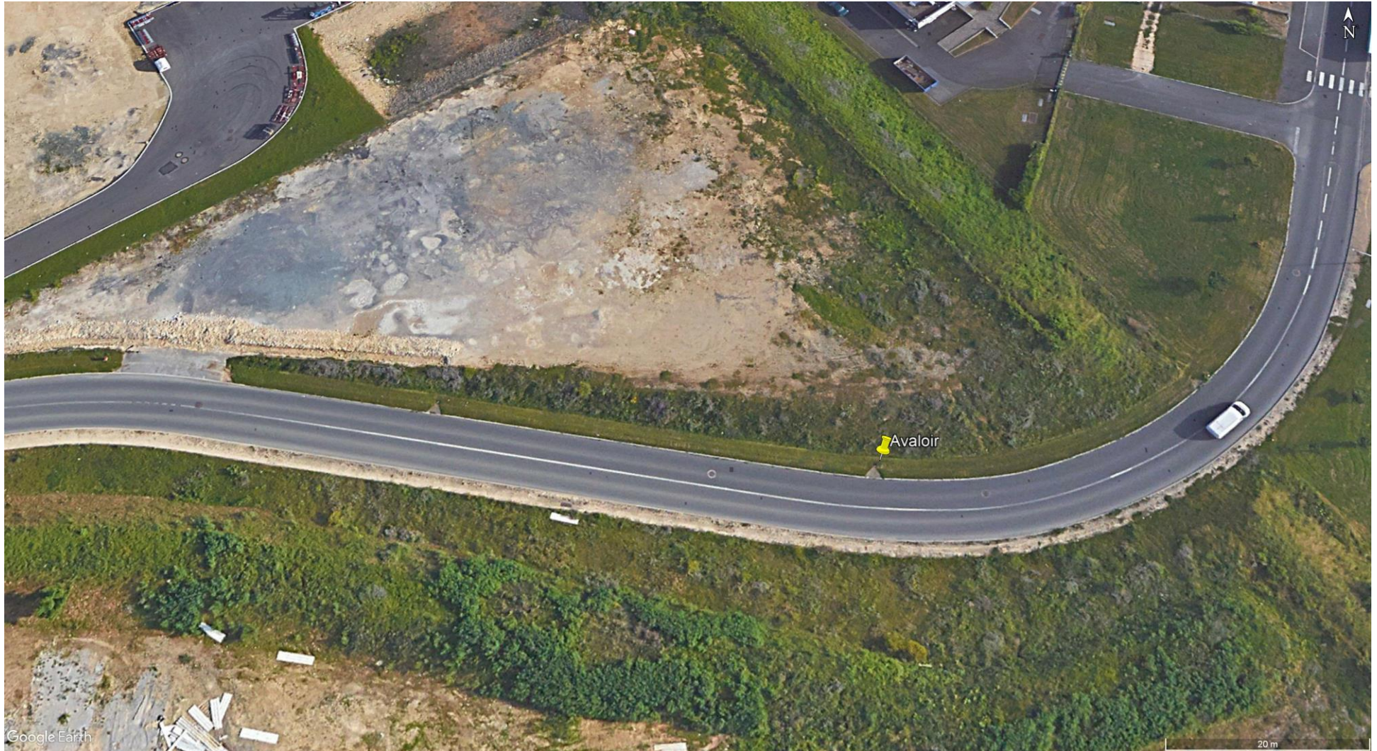
Figure 2 : Localisation de l'avaloir recevant la surverse (2/3)
