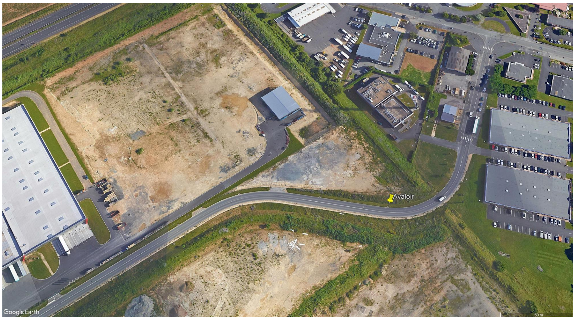
Figure 1 : Localisation de l'avaloir recevant la surverse (1/3)
